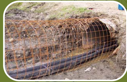
Grillage à ponceau
