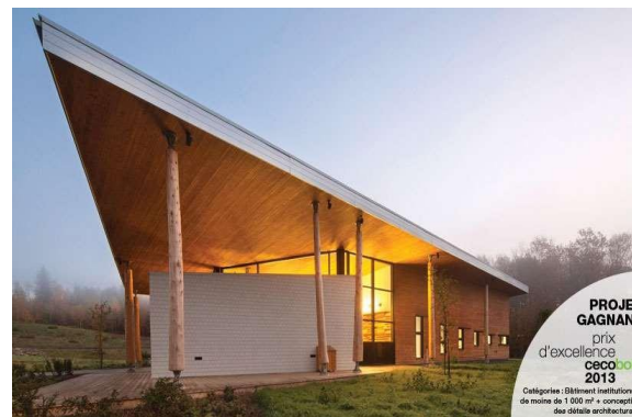
Pavillon d'accueil SÉPAQ
