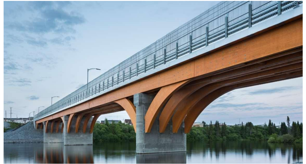
PONT DE LA RIVIÈRE MISTASSINI, QUÉBEC - 2014 CRÉDIT PHOTO : NORDIC STRUCTURES
