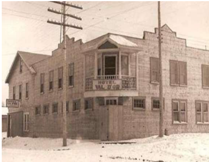
HÔTEL VAL D'OR - 1934 CRÉDIT PHOTO : CONSTRUCTION FGP
