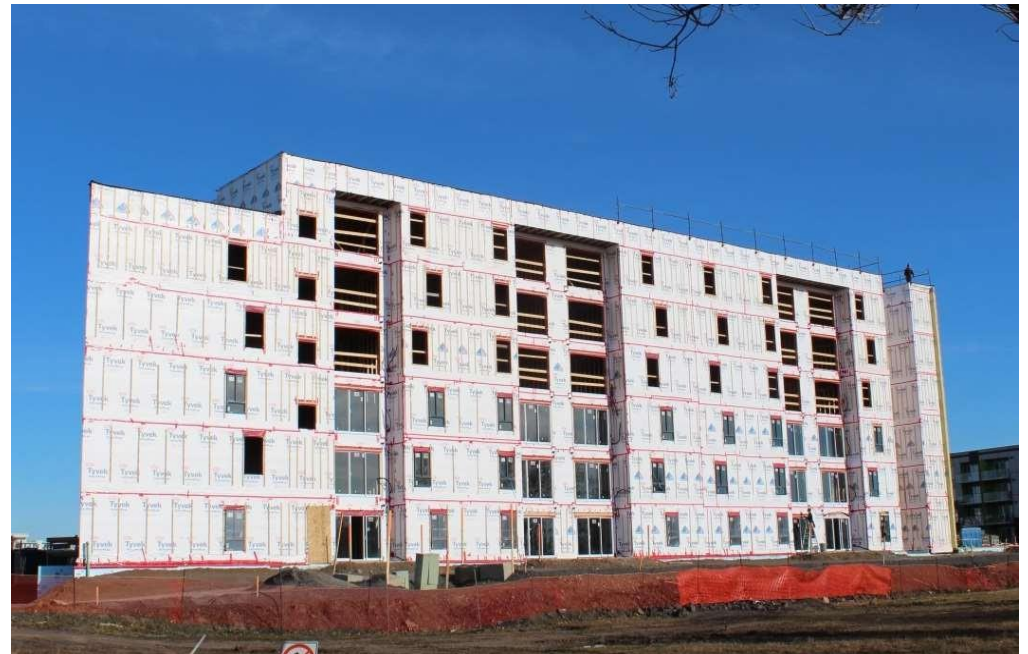
BÂTIMENT LE PRISME, QUÉBEC - 2020 CRÉDIT PHOTO : LOGISCO
